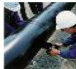
Fita asfáltica auto-adesiva produzida a base de asfaltos modificados com polímeros elastoméricos de alto poder de aderência, sobre diversas superfícies e na face inferior possui polietileno siliconado antiaderente. O produto disponível em várias medidas, oferece rápida aplicação e longa vida na proteção de tubulações enterradas.
