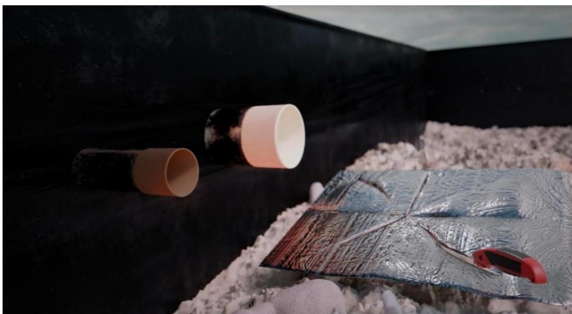
Os reforços são realizados em duas etapas. Na primeira etapa, corte um quadrado de manta e realize quatro cortes em forma de estrela com o tamanho suficiente para poder atravessar a tubulação.
