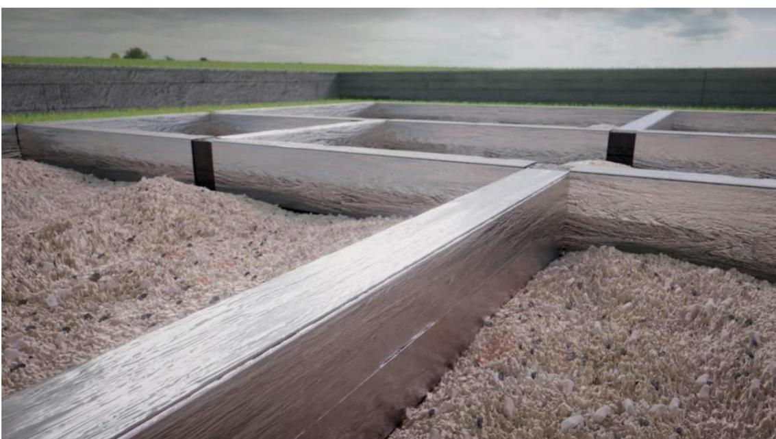
Sempre faça pressão sobre a manta para não ficar bolhas de ar e reforce a pressão e com rolete metálico nos acabamentos.
