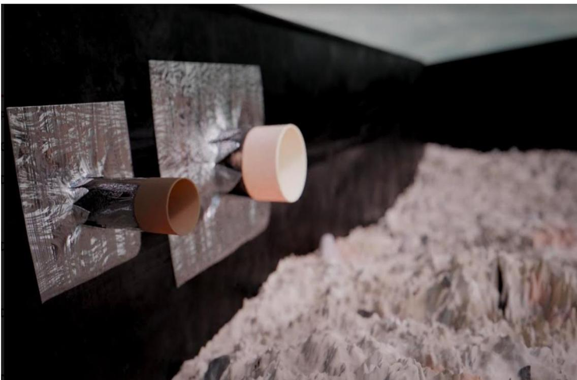
Segundo passo: recorte um retângulo de manta asfáltica com o comprimento necessário para envolver todo o perímetro do cano e mais 1/3, fazer três cortes (como mostra a imagem) para vedar perfeitamente a tubulação. Antes de remover o filme inferior antiaderente faça a moldagem da manta sobre a tubulação.
